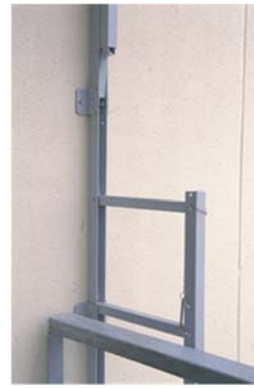
Kuva 3. Tikas aukaistuna jatkoksen kohdalla
