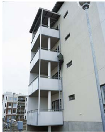
Kuva 5. Henkilö poistuu parvekkeelta
