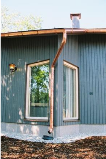
Kuva 3. P13 kuparikouru ja 100 mm kuparisyöksy
