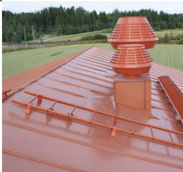
Lapetikkaat eli kattotikkaat asennetaan katolle turvaamaan lappeen suuntaista kulkua.
