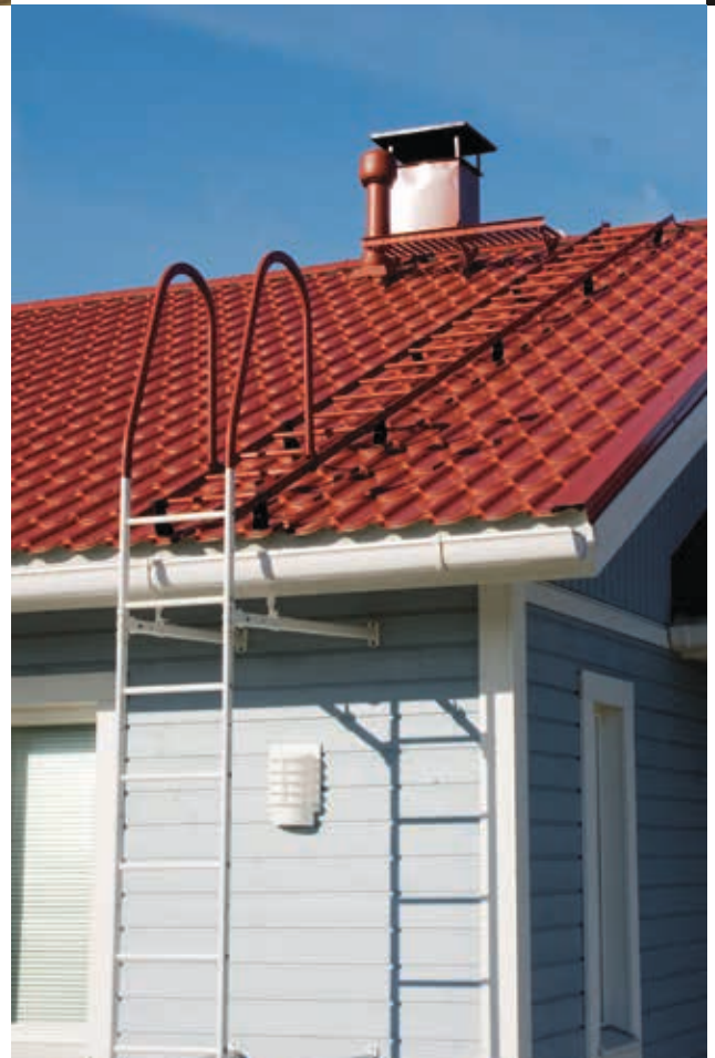
Puolipyöreät ja lujat kourut on varustettu vahvoilla ulkopuolisilla kannakkeilla, mikä helpottaa puhdistusta.
