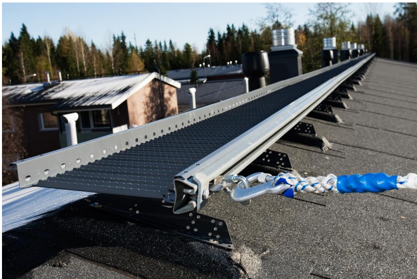
Joonis 1. Horisontaalrööbas katusesillal Horisontaalrööbas ja selle liugvanker
