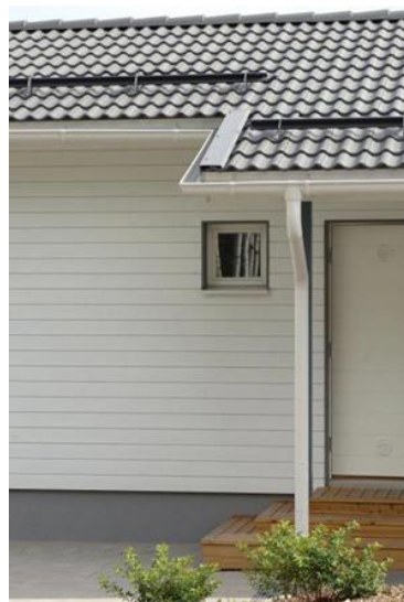
Joonis 2. K13 renn ja liugühendus
