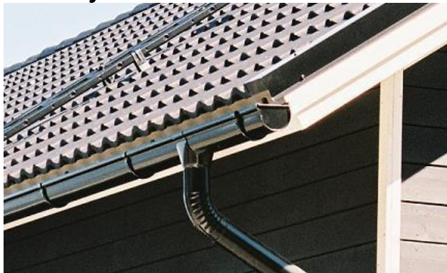
Joonis 1. P13 renn välise kanduriga ja liugühendus
