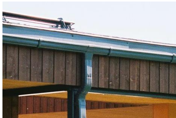
Joonis 2. K13 renn ja liugühendus
