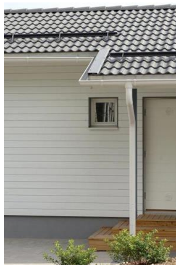
Bild 2. K13 ränna och stuprör
