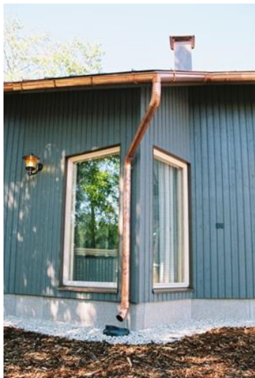
Bild 1. P13 ränna med utvändigt fäste och stuprör
