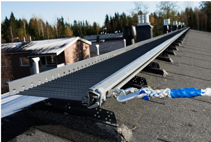
Bild 1. Horisontell skena i takbro skena och vagn
